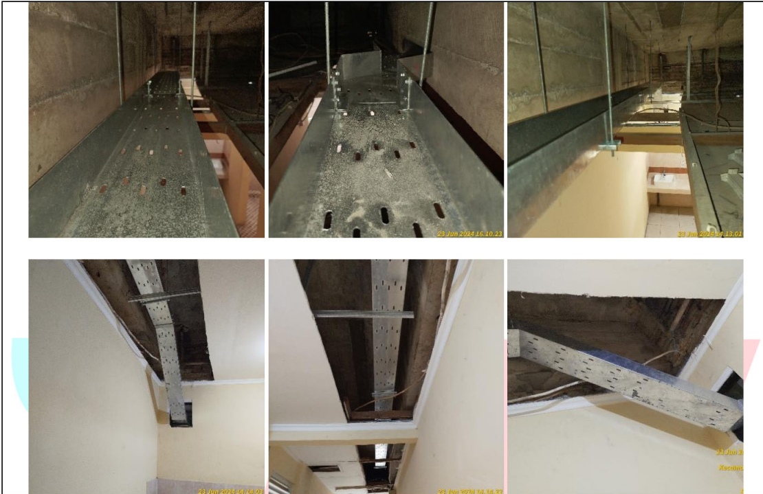
24 Juni 2024 – Pemasangan kabel tray
