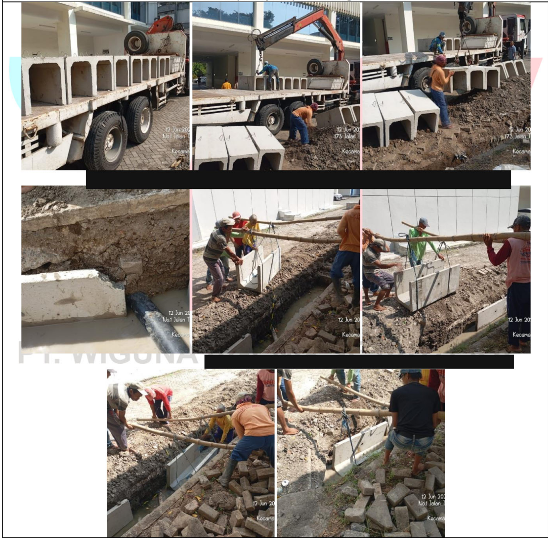
13 Juni 2024 - U-Ditch on site & pekerjaan pemasangan U-Ditch
