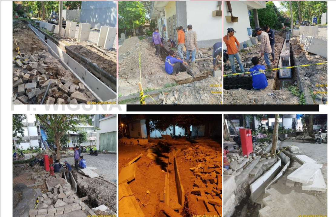
22 Juni 2024 –Pekerjaan pemasangan U-Ditch
