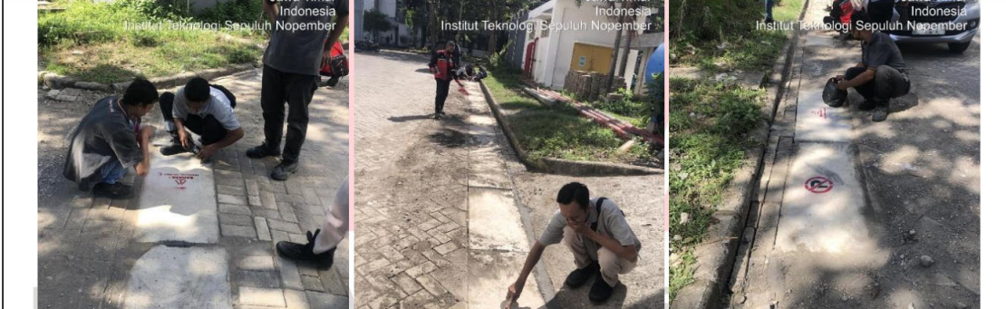
5 Juli 2024 - Perapian U-Ditch & pemberian tanda bahaya pada kabel tray & cover U-Ditch
