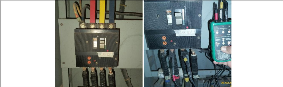
30 Juni 2024 - Phase Rotation test Gedung Statistik sebelum terminasi kabel
