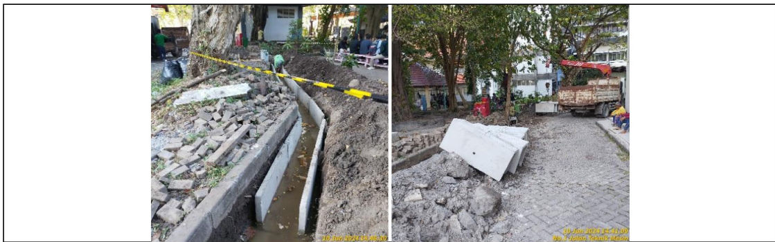
U-Ditch on site & pekerjaan pemasangan U-Ditch
