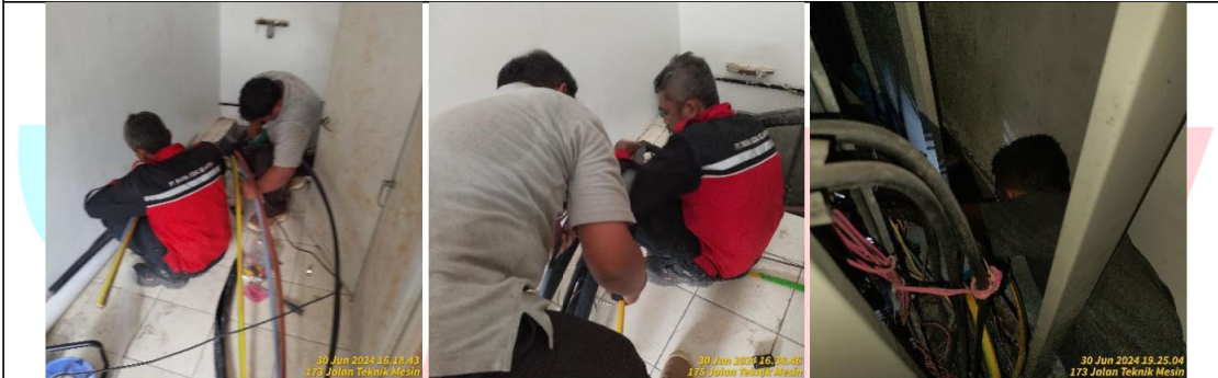
30 Juni 2024 - Insulation test sesudah terminasi kabel 95mm
