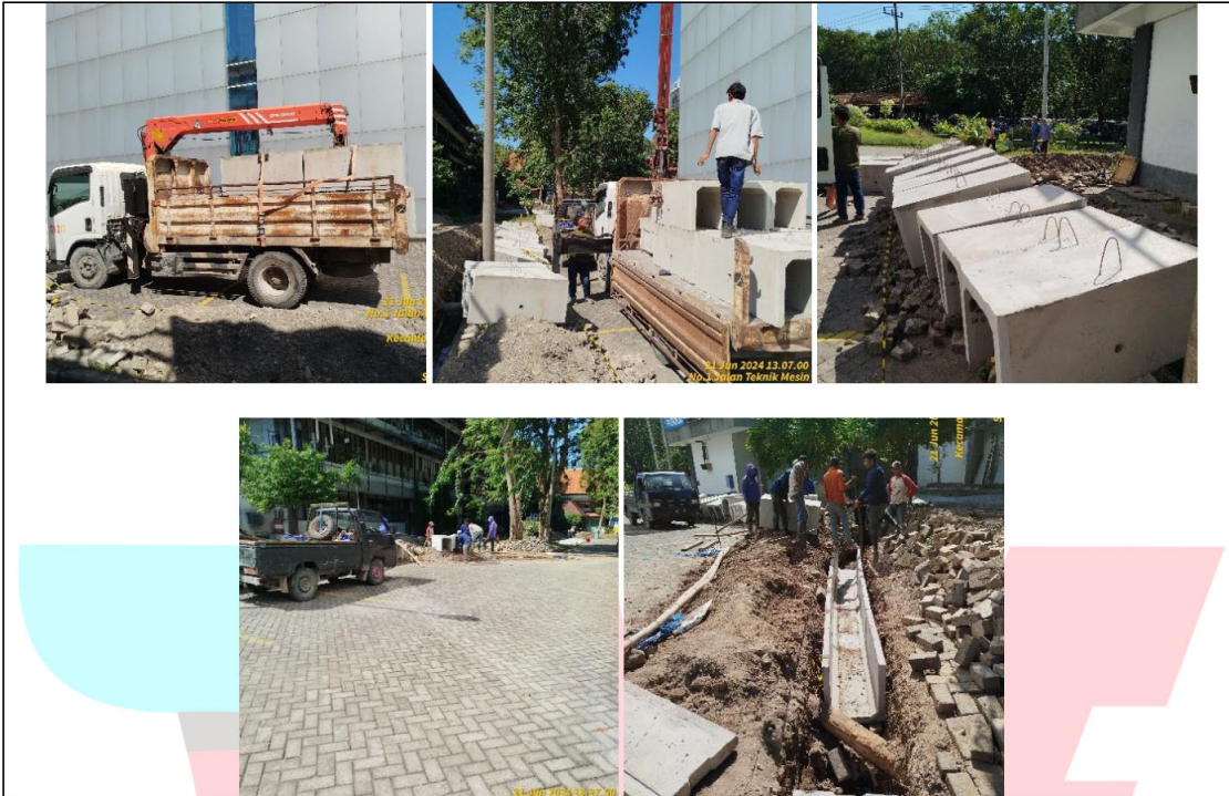
22 Juni 2024 –Pekerjaan pemasangan U-Ditch
