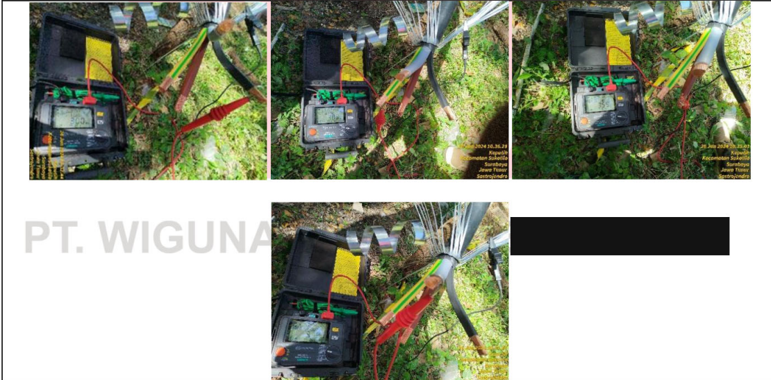
26 Juni 2024 - Insulation test Phase to Phase kabel 95mm sebelum dilakukan pulling
