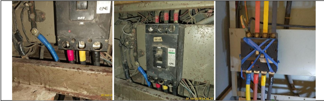
30 Juni 2024 - Terminasi kabel SS
